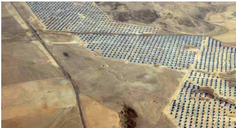
Солнечная электростанция на фотоэлектрических элементах в Абертуре занимает территорию более 200 гектар. Более 132 000 солнечных панелей, установленных на 2112 устройствах слежения за положением Солнца, обеспечивают суммарную пиковую мощность 23,1 мегаватт.
